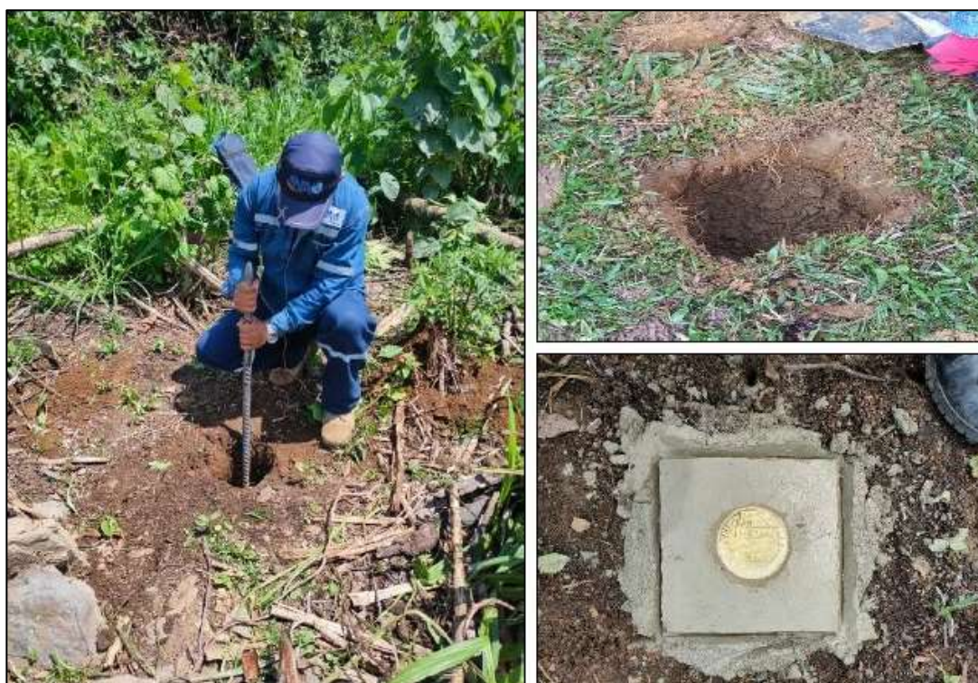
Figura 29. Proceso de Monumentación de los puntos
