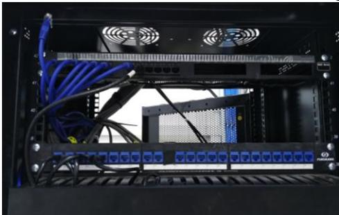
Todo el cableado de cámaras termina en un Pach Panel y luego es conectado al NVR
