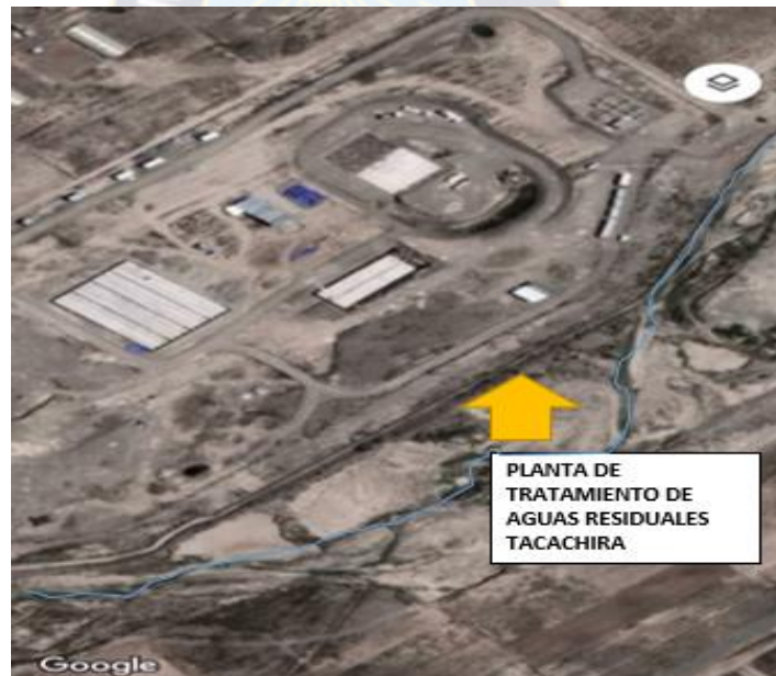
Figura 2: Planta de tratamiento de Aguas Residuales Tacachira en construcción.
