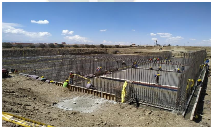
Figura 1: Vaciado de losa, para el tanque de sedimentación de Puchukollo
