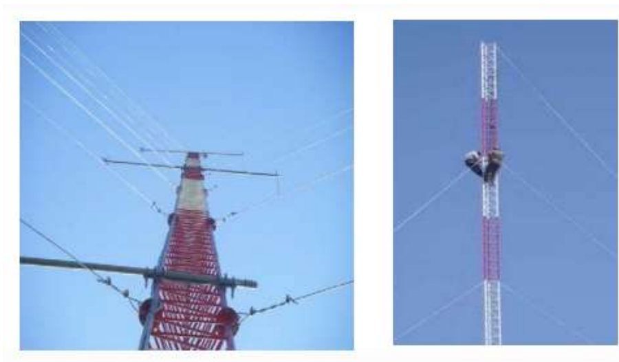
Figura 8 Torres arriostradas o atirantadas
