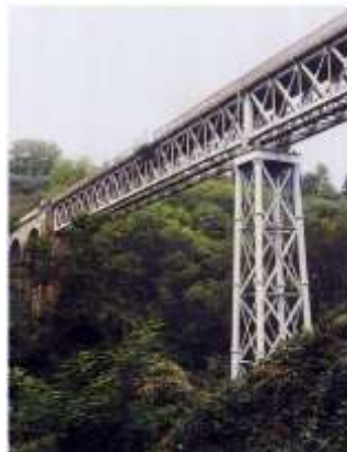
Figura 5 Gannat Francia, Viaducto de Neuvia
