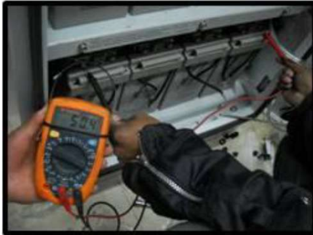
Figura 104 Prueba de voltaje
