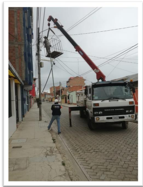
Montaje de cámaras y antenas direccionales en puntos específicos
