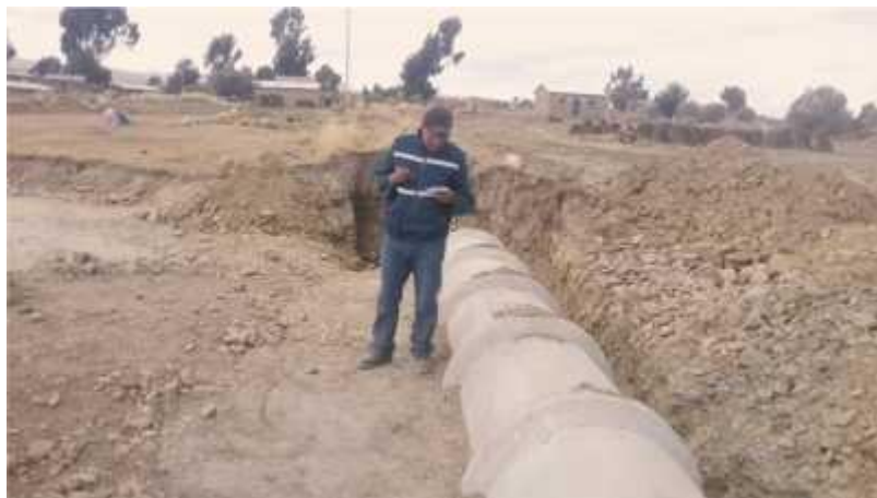
Figura N° 11 Relleno y Compactado
