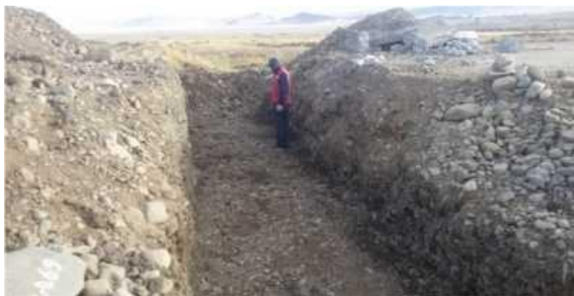
Figura N° 16 Corte en Talud para Alcantarilla
