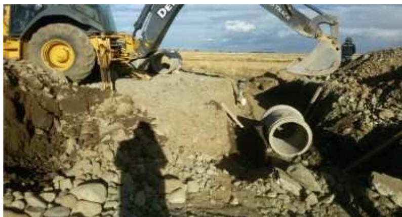
Figura N° 10 Ejecución e Instalación de Alcantarillas
