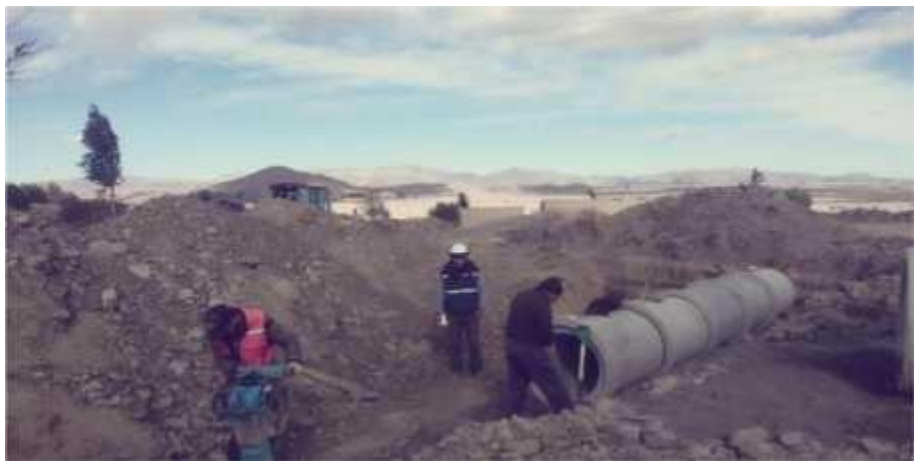
COMPACTACIÓN CON MATERIAL SELECCIONADO
