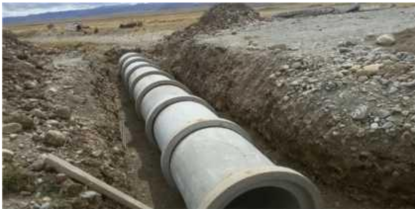
Figura N° 18 Instalado de Alcantarilla
