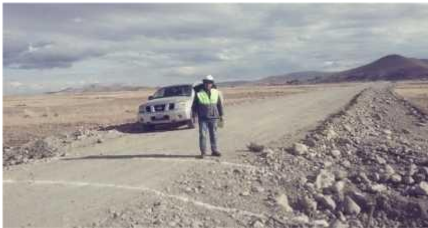
Figura N° 13 Localización de Alcantarillas
