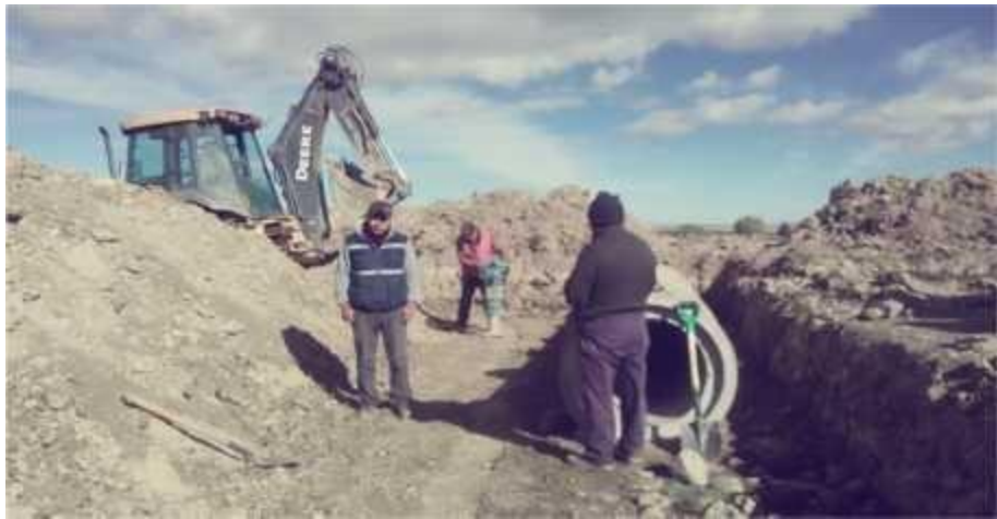
COMPACTACIÓN CON MATERIAL SELECCIONADO
