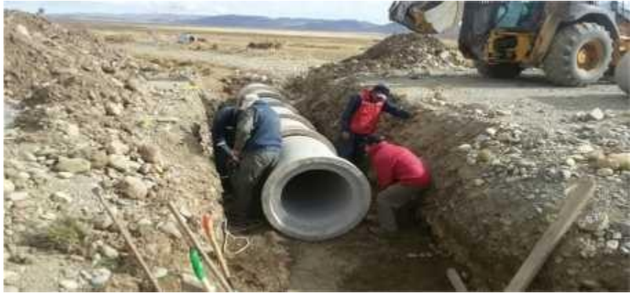
RELLENO Y COMPACTADO
