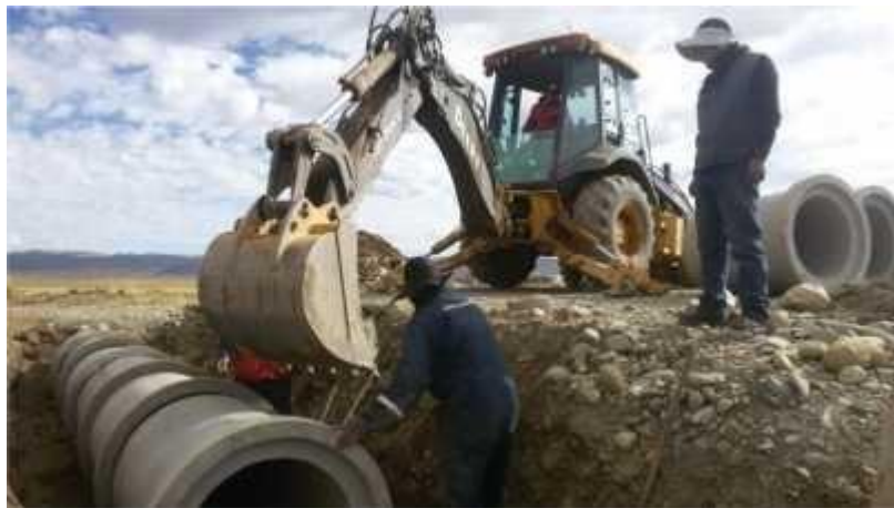
Figura N° 19 Instalación de Tubería con Retroexcavadora
