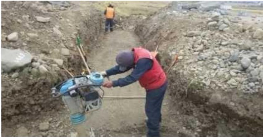
Figura N° 15 Excavación y Compactación de Cimentación
