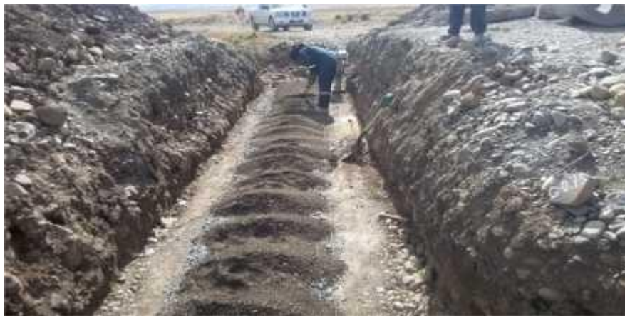
Figura N° 7 Proceso de Colocación de la Cama
