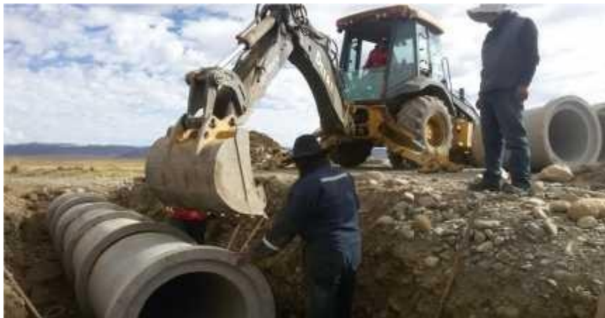
Figura N° 8 Instalación de Alcantarillas
