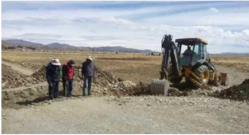
Figura N° 14 Excavación de las Alcantarillas
