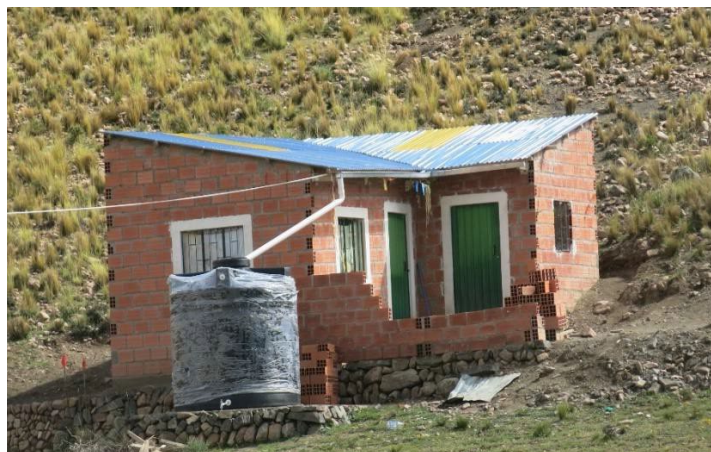
SISTEMA DE COSECHA PLUVIAL RUSTICO PARA USO DOMESTICO
