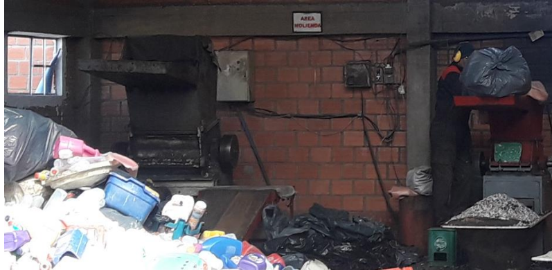
Ilustración 13: Dotación de EPP no adecuadas
