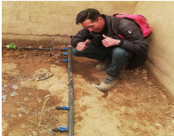
Instalación de los accesorios y cintas del riego por goteo.
