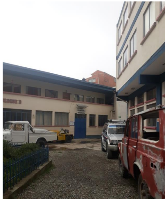
Foto No. 16: Bloque D aulas de la Carrera Mecánica Industrial Técnico Superior
