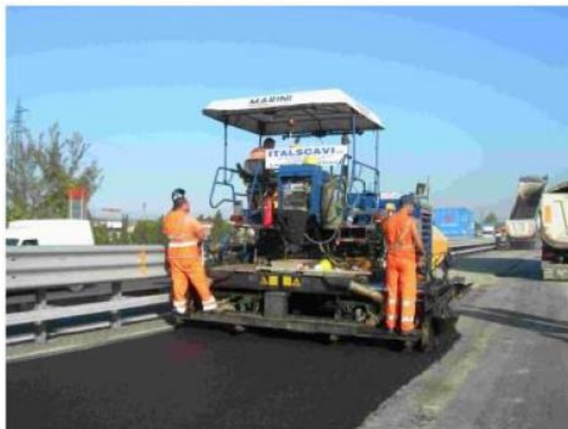
Figura N° 26. Ausencia de emisiones durante el colocado de la mezcla tibia
