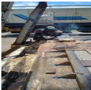
*Fig. 38: Reemplazo de planchas.*
