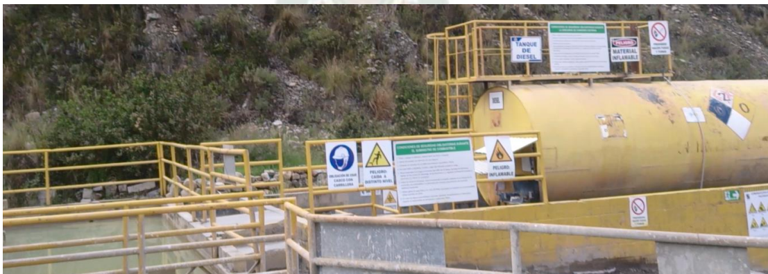
FIGURA 3-3 PISCINAS DE DECANTACIÓN Y FILTRACIÓN
