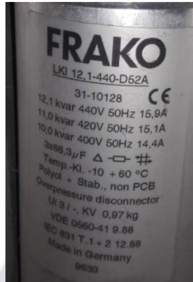
Figura 7.1 Características Técnicas Capacitor
