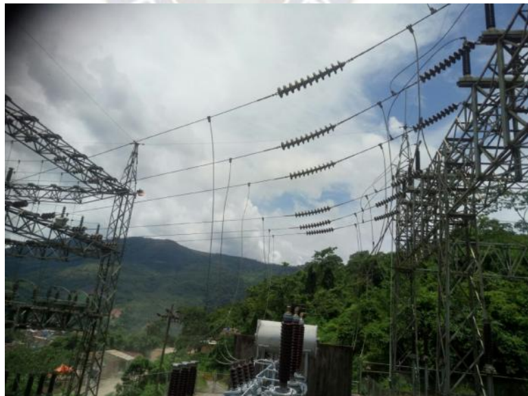
Fotografía Muestra las barras en 115 kV
