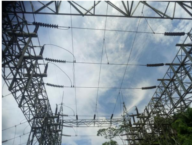
Fotografía Muestra las barras en 115 kV
