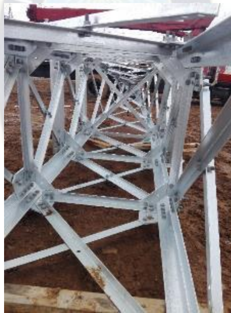
Figura 50 - Armado de viga para pórtico - S/E Mazocruz
