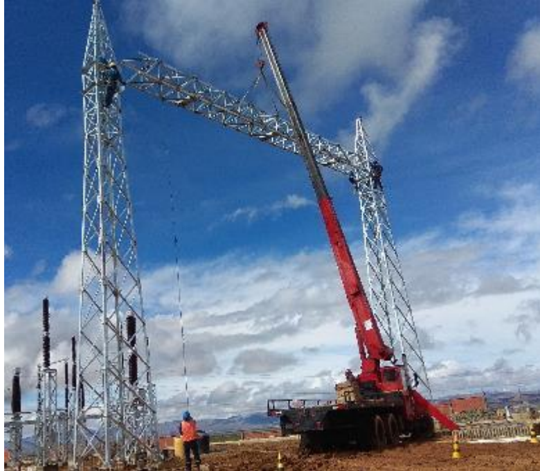
Figura 48 - Montaje pórtico S/E Mazocruz (Estructura en celosía)
