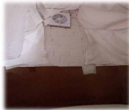
Figura 11. Extractor/ventilador en campana de cría. (Elaboración propia)
