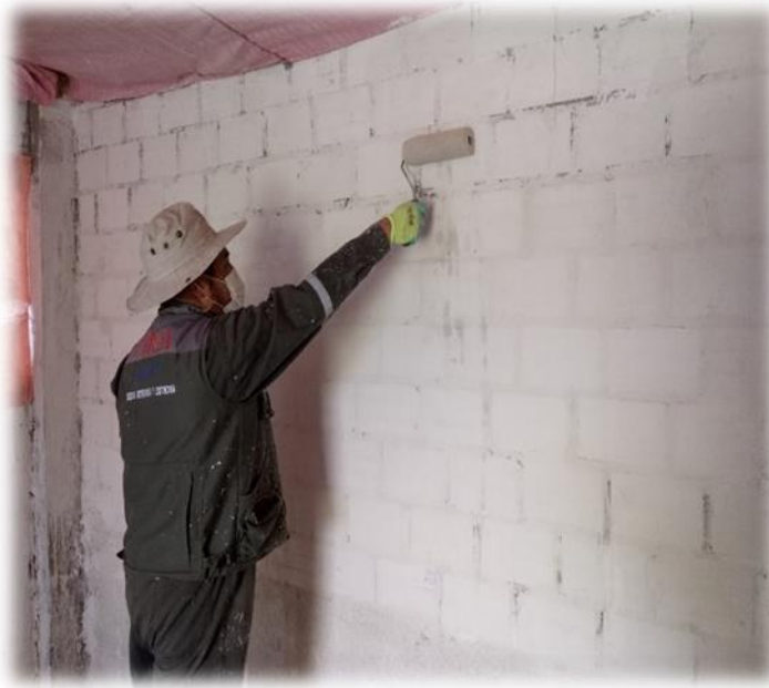
Figura 7. Caleado de paredes. (Elaboración propia)
