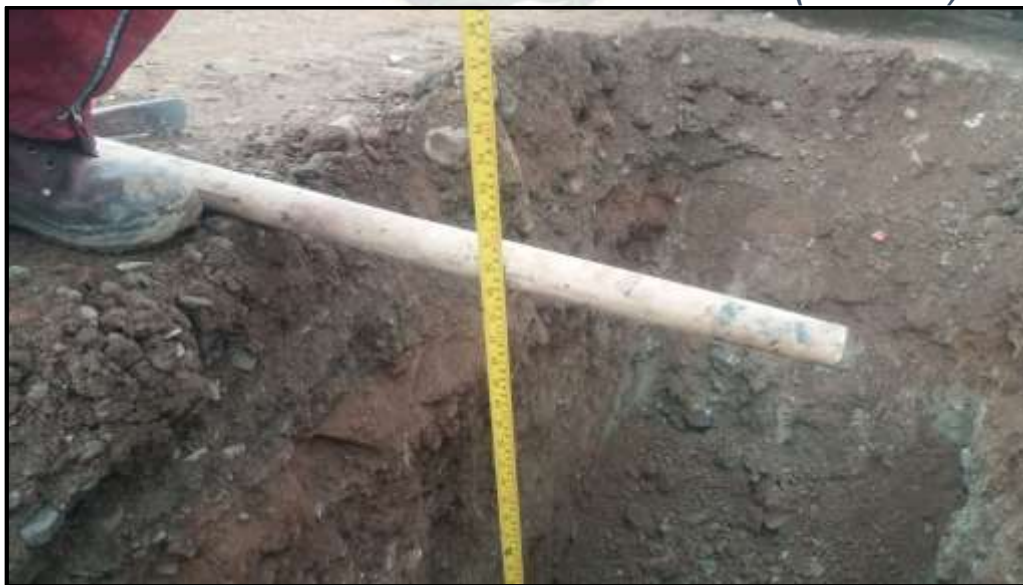
FIGURA 3. 12 Extracción de muestras de Suelo (calicata 8).
