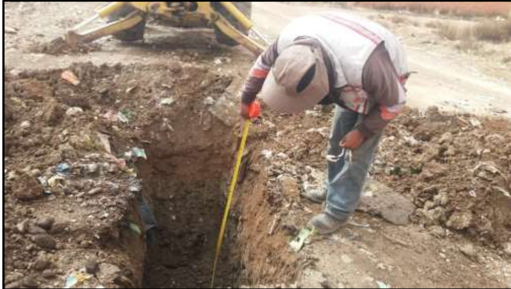
FIGURA 3. 11 Extracción de muestras de Suelo (calicata 4).
