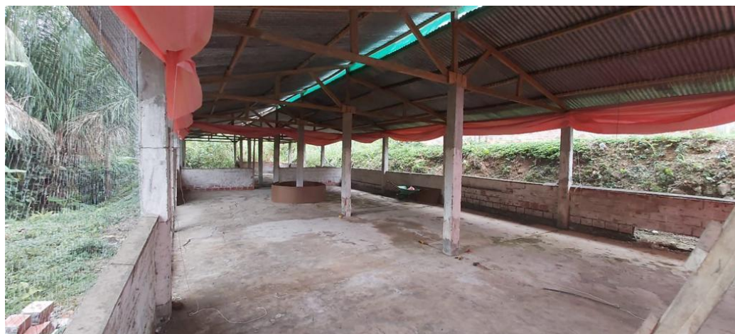
Anexo 8. Galpón ya refaccionado
