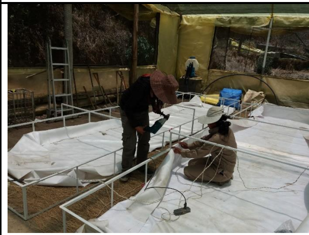
Forrado con lona impermeable
