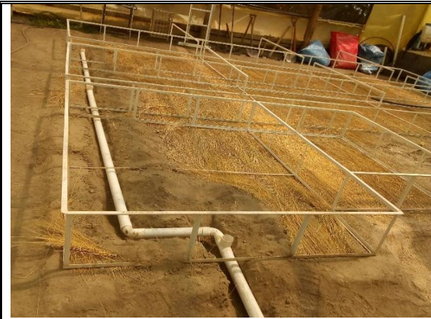
Instalación de tuberías de evacuación
