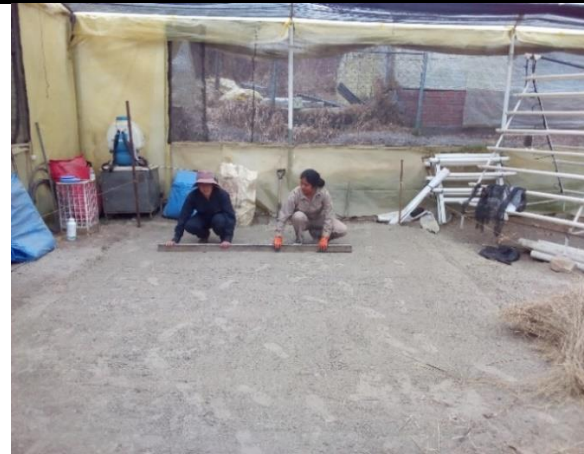
Nivelado del área experimental
