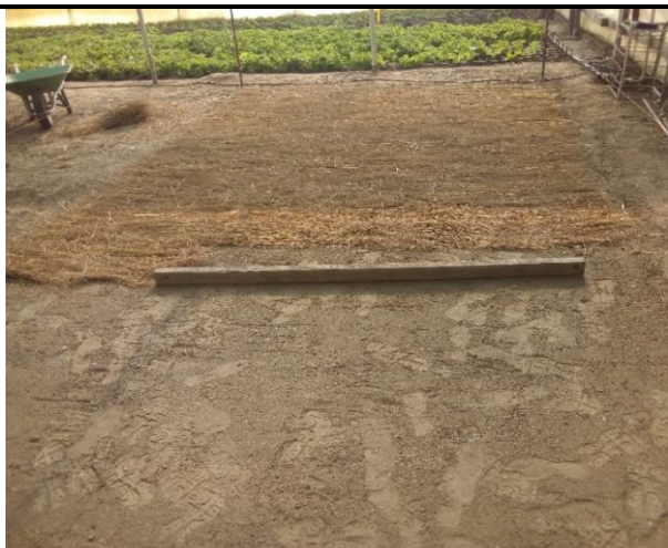
. Colocado de paja en la superficie
