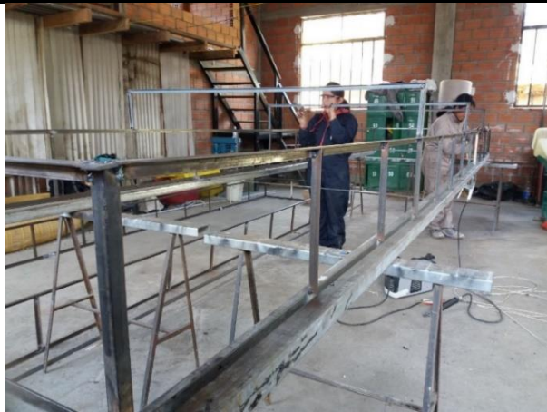
Armando de la estructura
