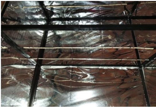
Figura 15. Instalación de luces de iluminación cintas LED 5050-IP65.
