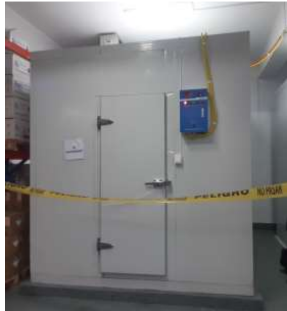
INTALACIÓN DE CÁMARA DE FRÍO 2
