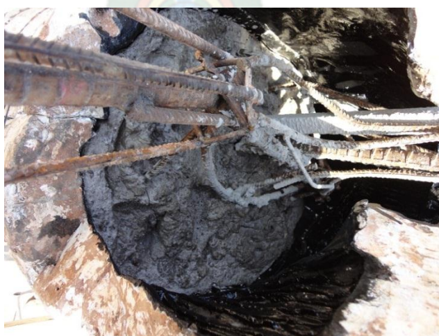
Foto 26 Vaciado con la mezcla de hormigón para la obtención del positivo
