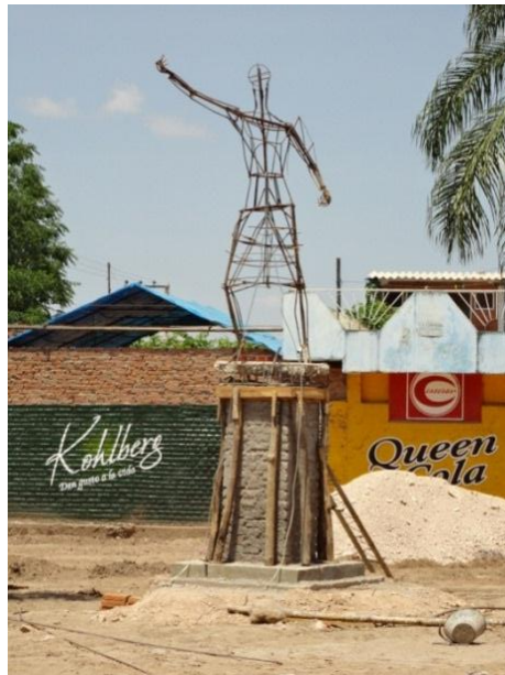
Emplazamiento de la estructura sobre pedestal
