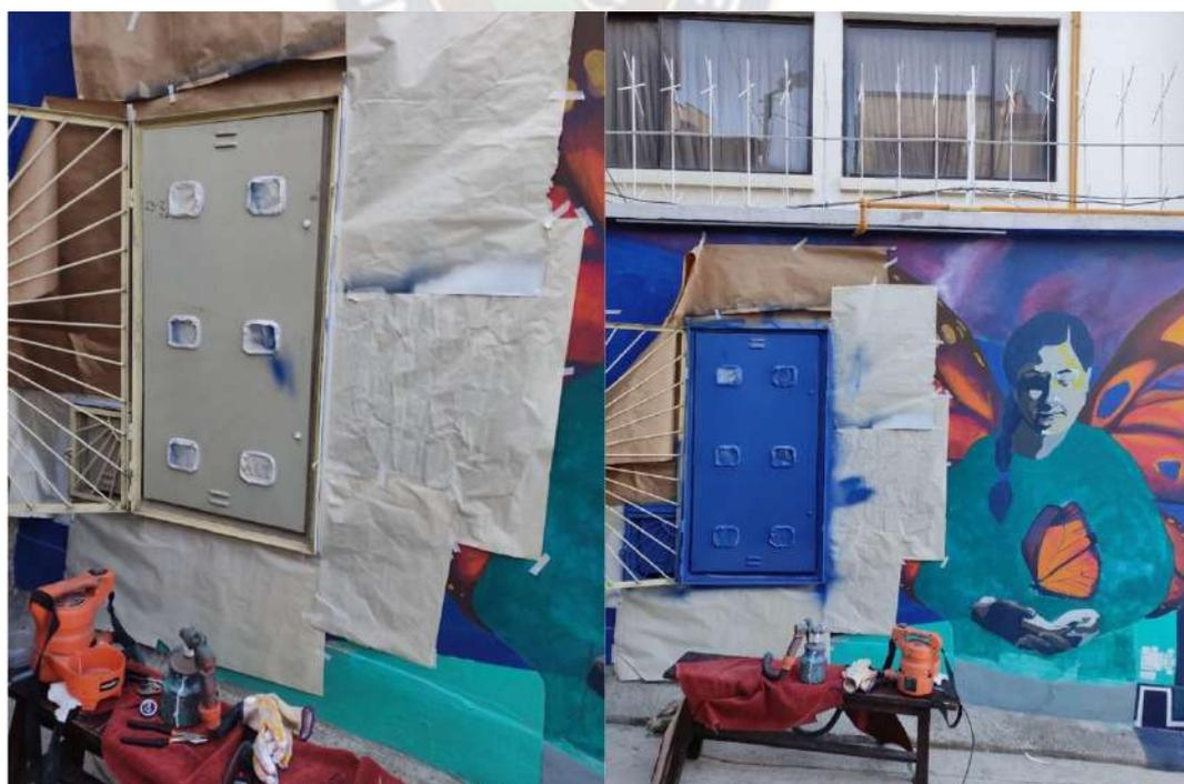
*Ilustración 54 Proceso de pintado de caja para medidores de gas*
