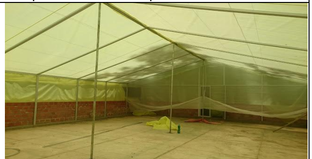
Vista interna con malla antiafido del invernadero
