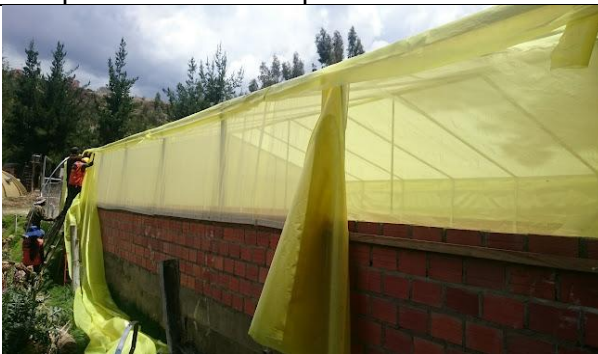
Proceso de techado del invernadero con agro film
