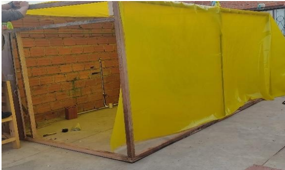
Fotografía 1. Construcción de ambiente atemperado en Pampahasi Bajo.
