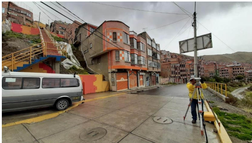
Figura 35 – Materialización de puntos de control GPS/GNSS
