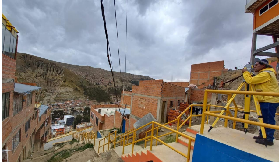
Figura 43 – Proceso de medición con equipo topográfico (Estación total)
