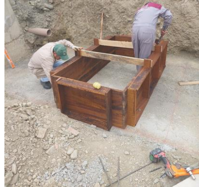
Figura A4.7 Colocado de encofrado. Fuente: Elaboración Propia
