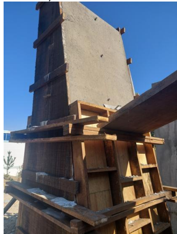
a) Desencofrado
