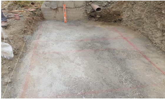
Figura A4.6 Replanteo de cimentación. Fuente: Elaboración Propia
