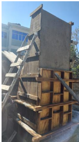
Figura 3.23 Desencofrado y curado de muro.
