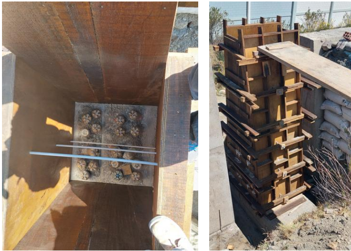
Figura A4.11 Encofrado cuerpo de muro. Fuente: Elaboración Propia
