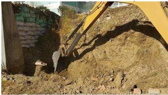
Figura A4.1 Excavación. Fuente: Elaboración Propia
