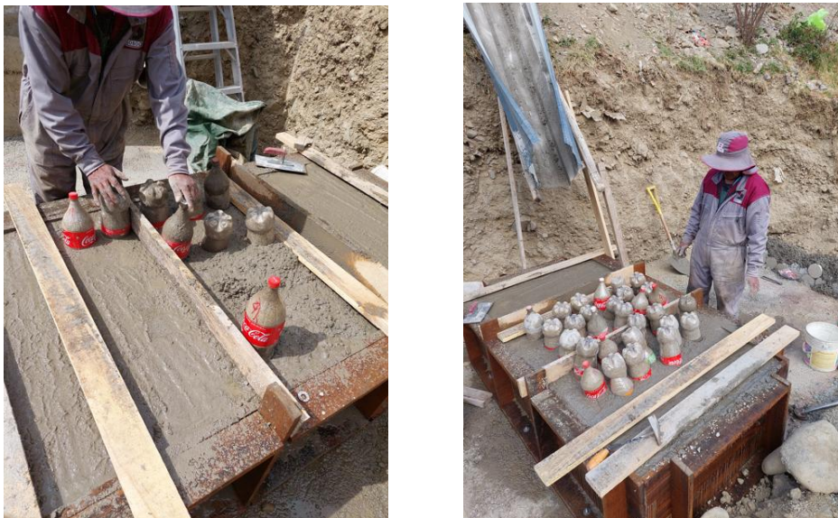
Figura 3.20 Colocado de botellas de espera.
