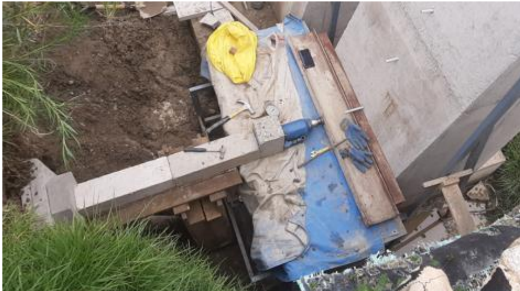
Figura 3.30 Disposición del gato hidráulico.
