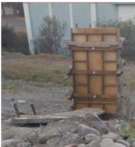
Figura 3.22 Tercera etapa de vaciado.
