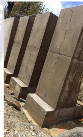
Figura 3.1 Vista lateral y frontal de los muros de hormigón ciclópeo pet.
