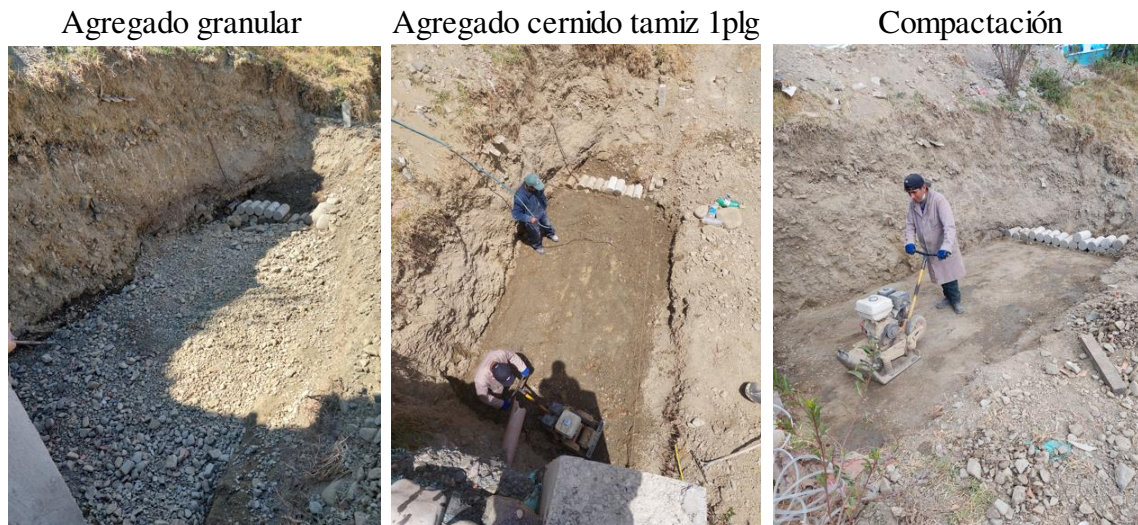
Figura 3.14 Proceso de compactación del suelo por capas.
