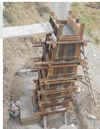
Figura 3.22 Tercera etapa de vaciado.
