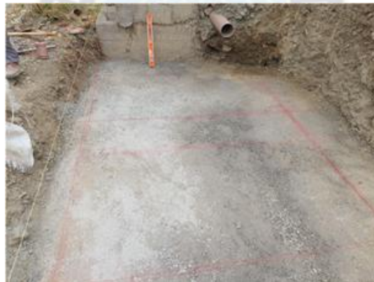
Figura 3.15 Carpeta de hormigón pobre.
