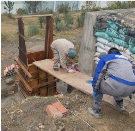
Figura 3.21 Segunda etapa de vaciado.
