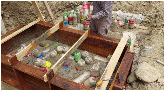
Figura A4.8 Primera camada de botellas. Fuente: Elaboración Propia
