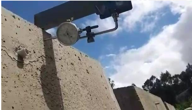
“E3” Corona de Muro – Medición Horizontal
