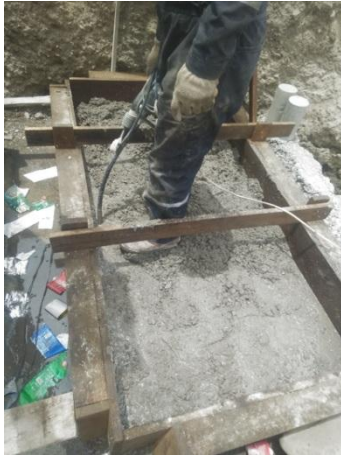
Figura A4,9 Segunda capa de hormigón. Fuente: Elaboración Propia
