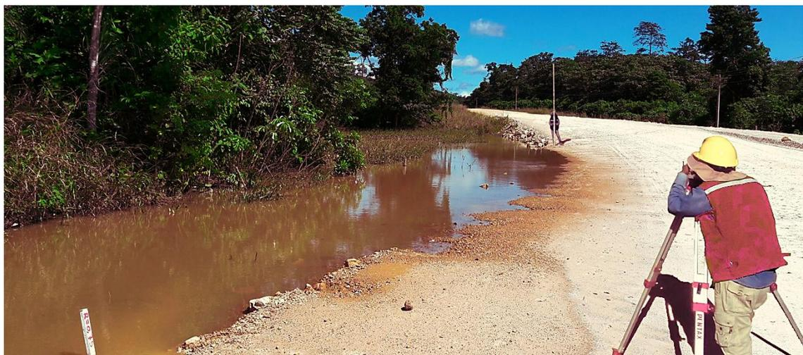
Fotografía No. 14 - Trabajo de nivelación geométrica de la primera brigada
