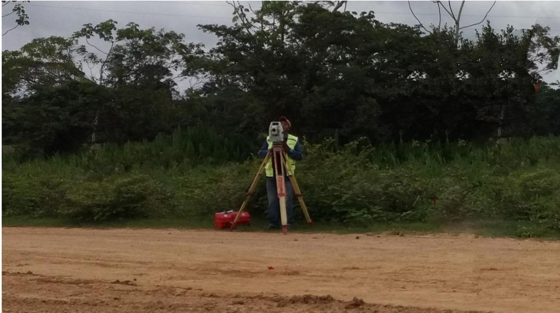
Fotografía No. 16 - Levantamiento topográfico con estación total
