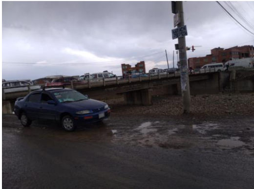
Figura 4. Ubicación Puente Bolivia – rio Seco.
