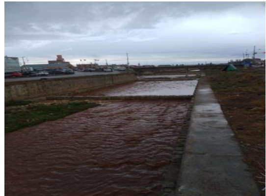
Figura 5. Ubicación Puente Bolivia – rio Seco.
