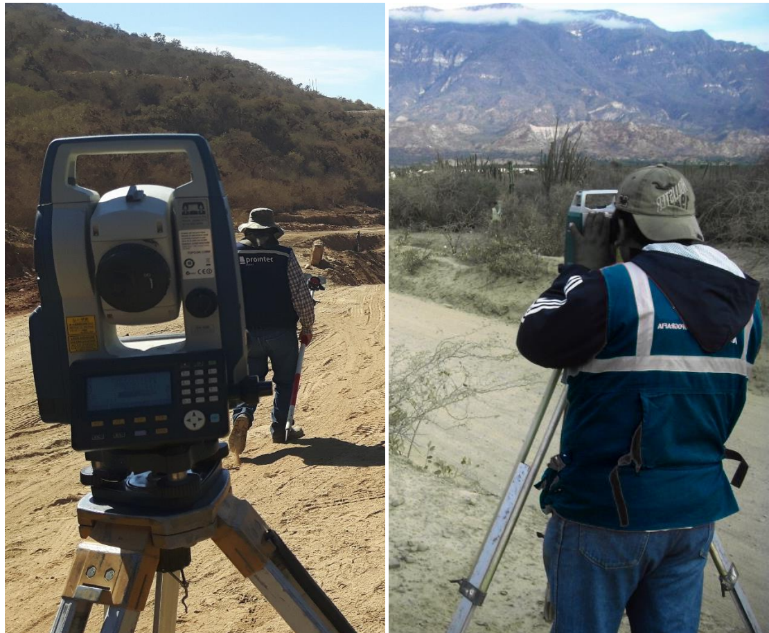
Figura No. 41 - Mediciones con Estación Total de pares geodésicos Fuente. Elaboración propia
