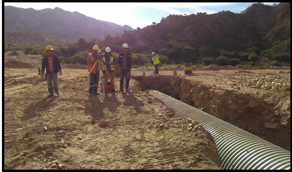
Figura No. 51 - Liberación Topográfica en alcantarilla progresiva 76+569 Fuente. Elaboración propia
