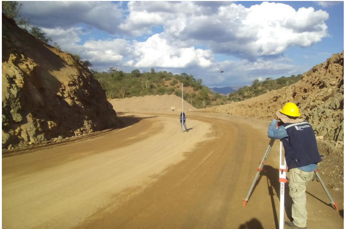
Figura No. 47 - Nivelación geométrica de puntos de control vertical de ida y vuelta Fuente. Elaboración propia
