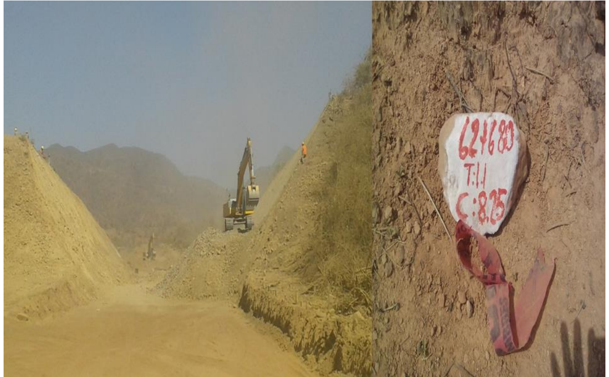
Figura No. 49 - Control geométrico en progresiva 62+680 Fuente. Elaboración propia
