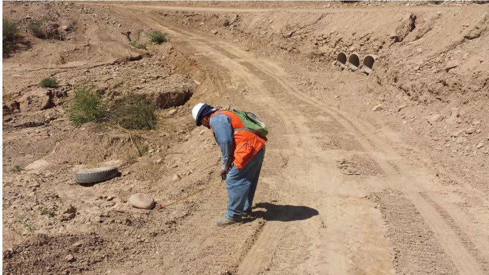
Figura No. 30 - Inspección en campo Fuente. Elaboración propia
