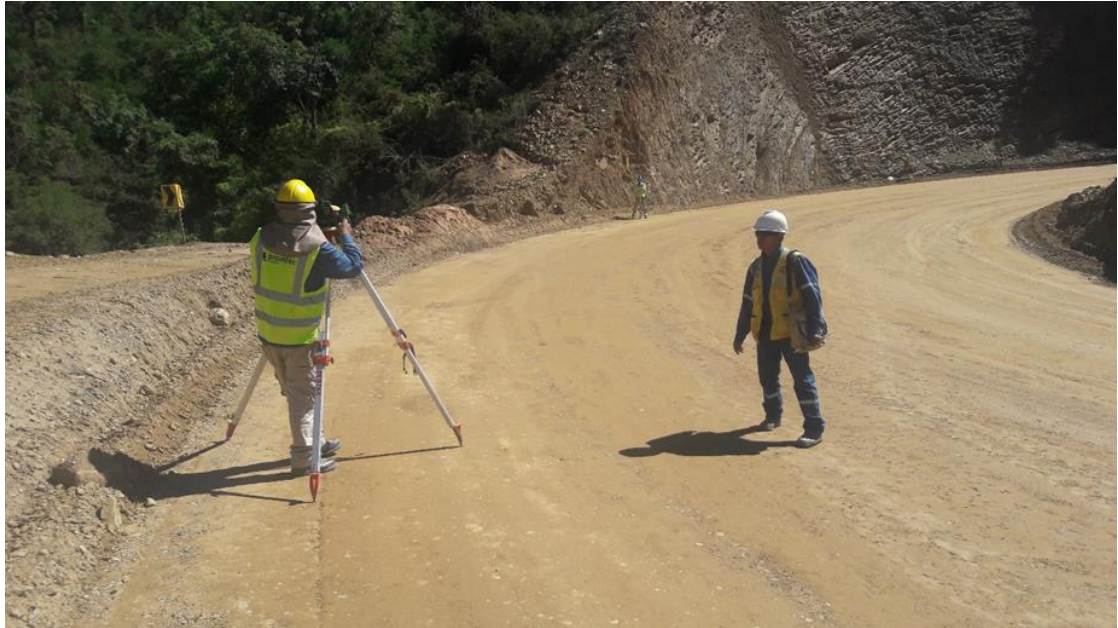
Figura No. 53 - Liberación de capa Sub Base Fuente. Elaboración propia
