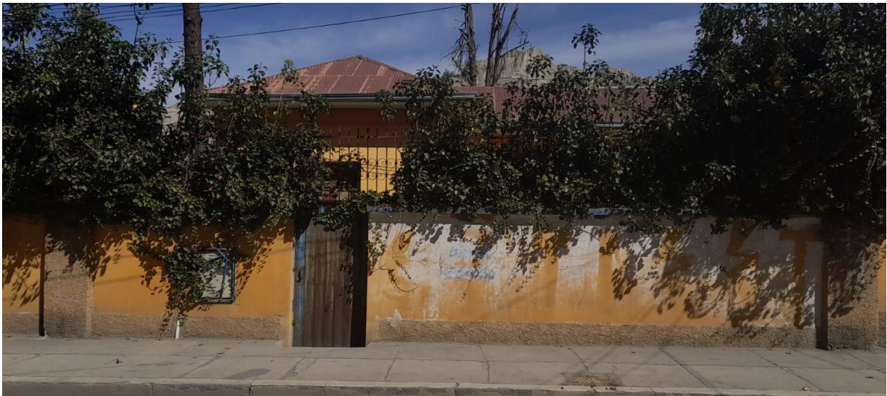
Figura 53 Fotografía del estado inicial de los muros #2 y #3
