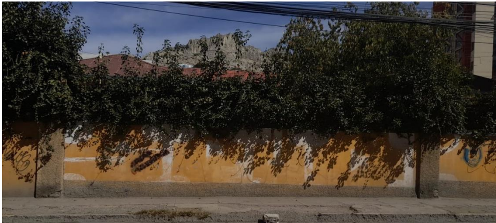
Figura 55 Fotografía del estado inicial del muro #6
