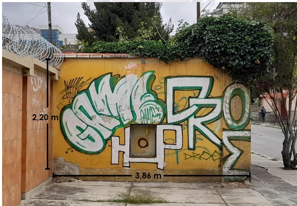
Figura 16 Muro previo al pintado de mural de prueba ubicado en la calle 4 de Obrajes sobre la Av. Ormachea, La Paz, Bolivia
