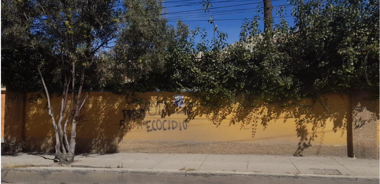
Figura 52 Fotografía del estado inicial del muro #1
