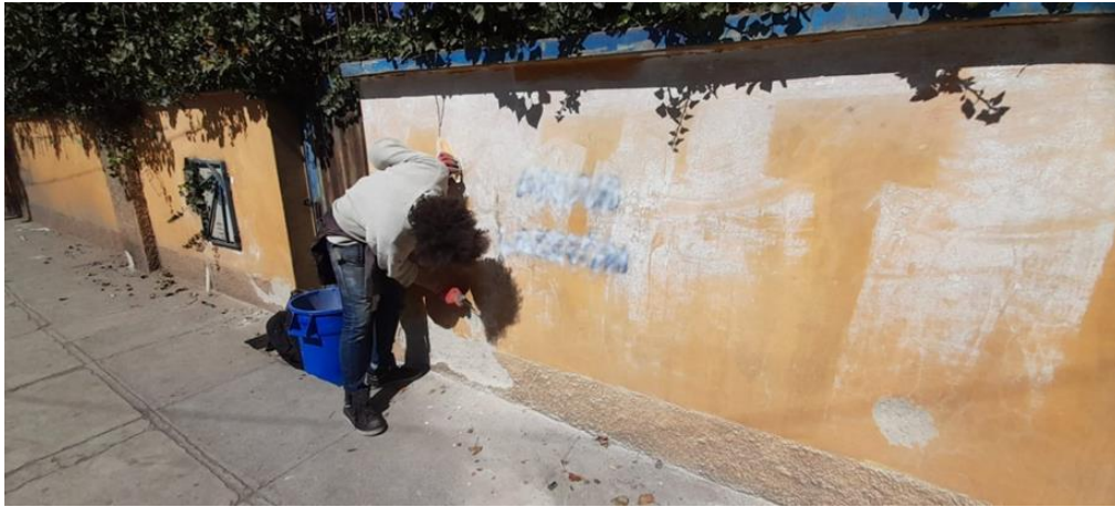
Figura 71 Fotografía del proceso de restauración de muro #3
