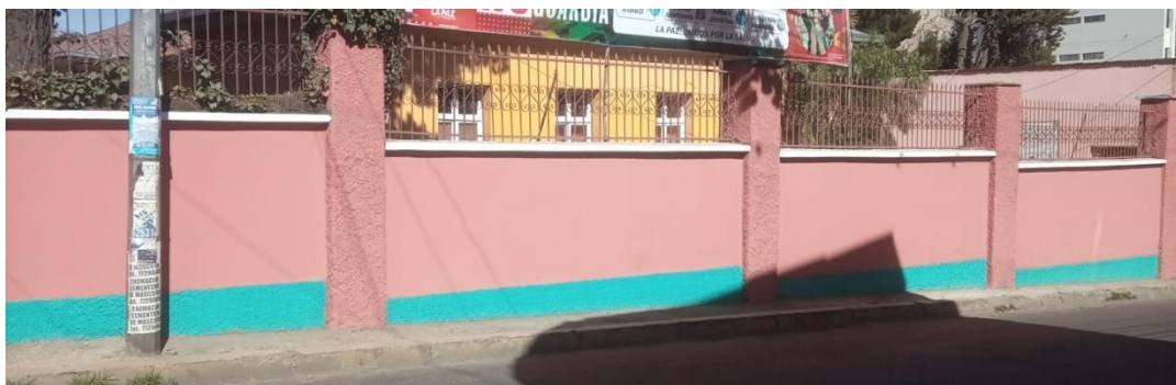
Figura 88 Fotografía #3 del pintado por parte de los albañiles del SEDEGES de los muros externos del Centro de Acogida Niño Jesús sobre la calle 3 de Obrajes.
