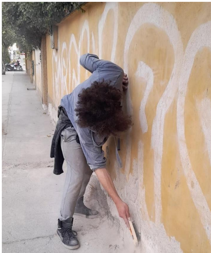
Figura 37 Fotografía tomada durante el proceso de restauración de los muros a pintar
