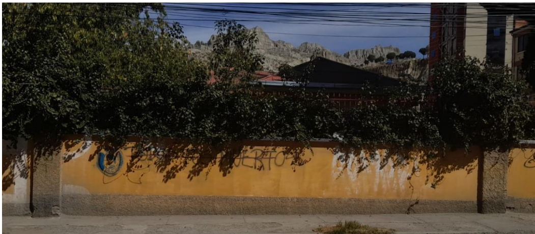
Figura 56 Fotografía del estado inicial del muro #7
