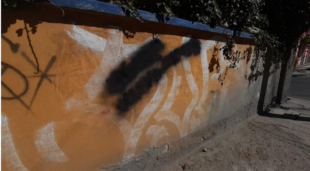
Figura 36 Muestra del estado inicial del muro #8 antes de ser pintado
