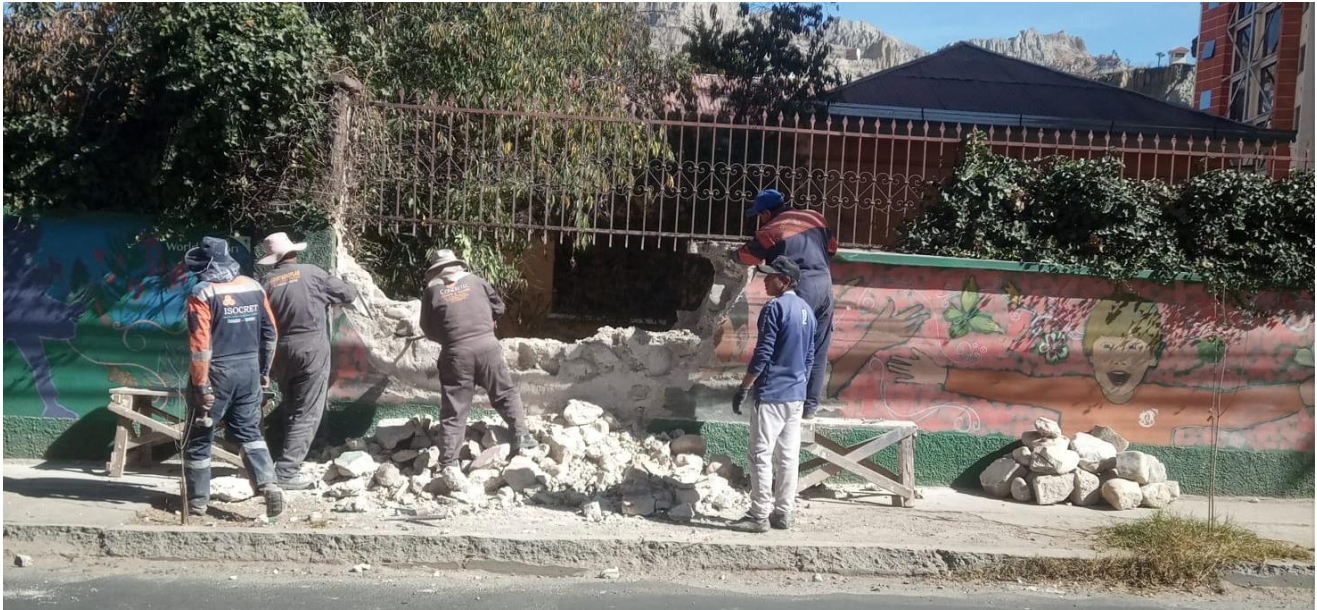
Figura 84 Fotografía de la demolición del “muro #7”, a causa de un accidente automovilístico, por riesgo de derrumbe.
