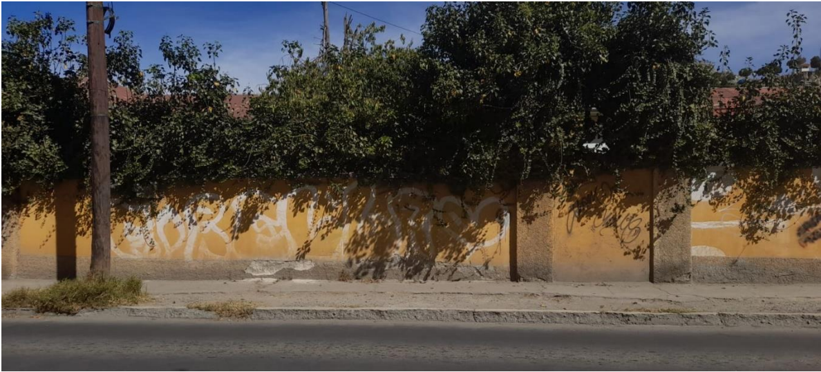
Figura 54 Fotografía del estado inicial de los muros #4 y #5
