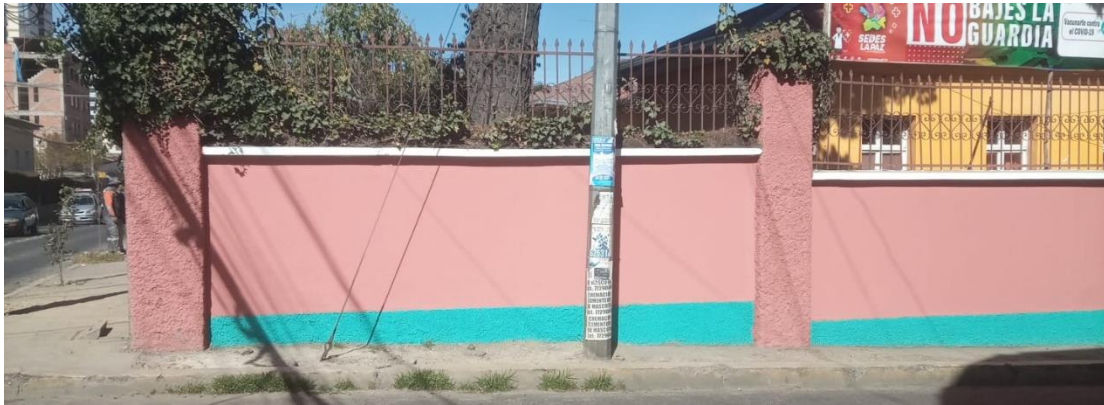
Figura 86 Fotografía #1 del pintado por parte de los albañiles del SEDEGES de los muros externos del Centro de Acogida Niño Jesús sobre la calle 3 de Obrajes.
