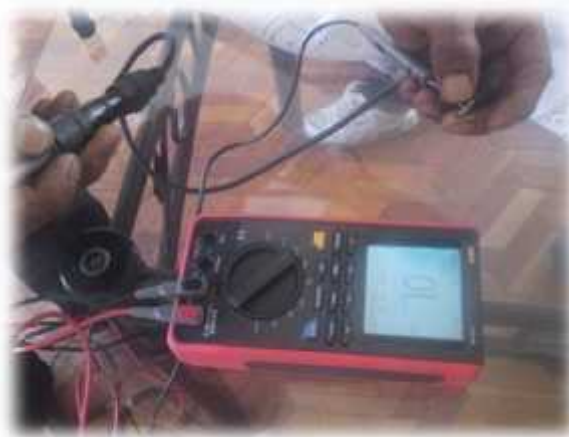
Figura 27: Medición de cables de alta tensión
