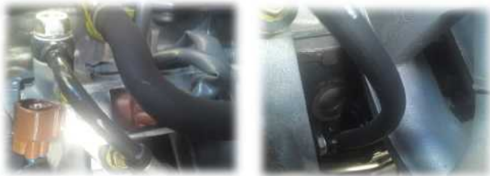
Figura 65: Armado con sello nuevo
