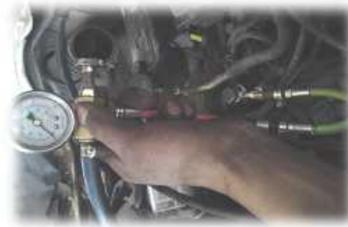
Figura 37: Instalación del manómetro
