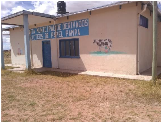
Figura 2. Planta de derivados lácteos, vista frontal
