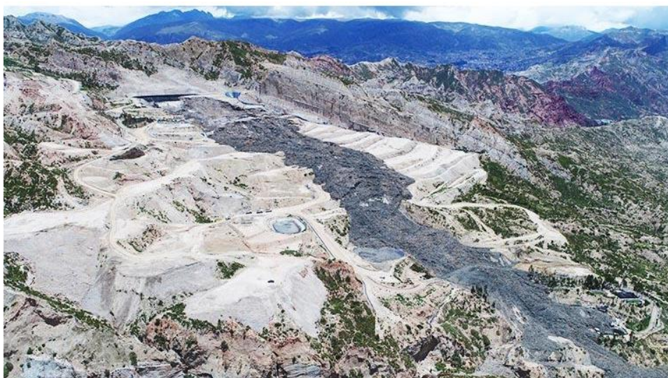
Figura 2 Colapso de relleno sanitario de Alpacoma La Paz. Fuente: MARKA REGISTRADA prensa (Los tiempos, 2019)
