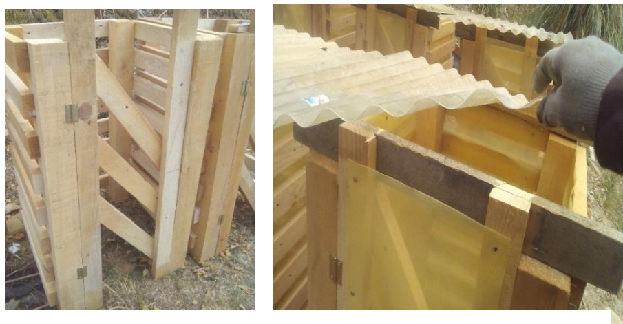
Figura 9 Construcción de las composteras
