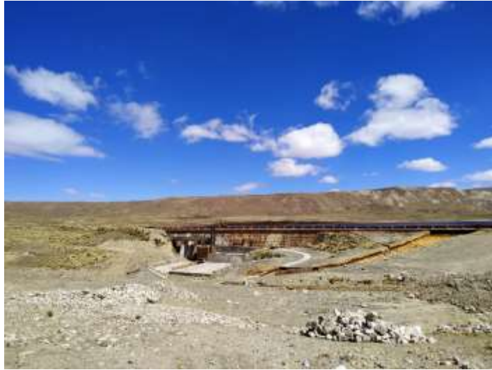
Figura 24. Construcción de una presa para contener las aguas de la laguna Milluni Grande
