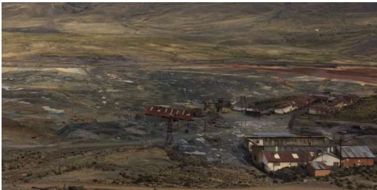
Figura 23. Instalaciones del antiguo campamento minero y sus pasivos ambientales
