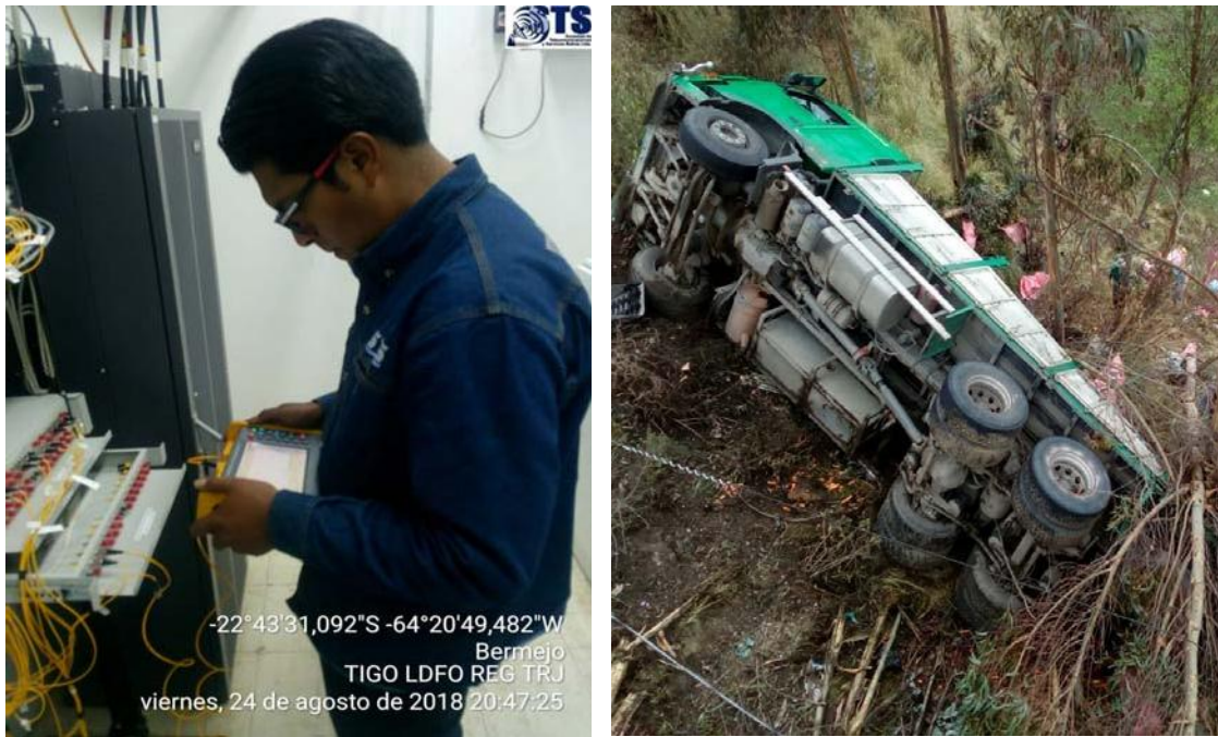
Figura 24. Personal realiza medidas ópticas con equipo OTDR en Sitio. Accidente de tránsito ocasiona corte de fibra óptica
