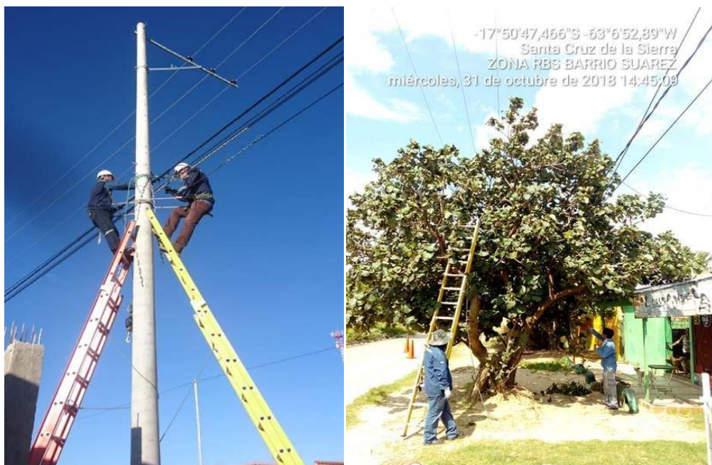
Figura 17. Instalación de ferretería y liberado de cable de fibra óptica
