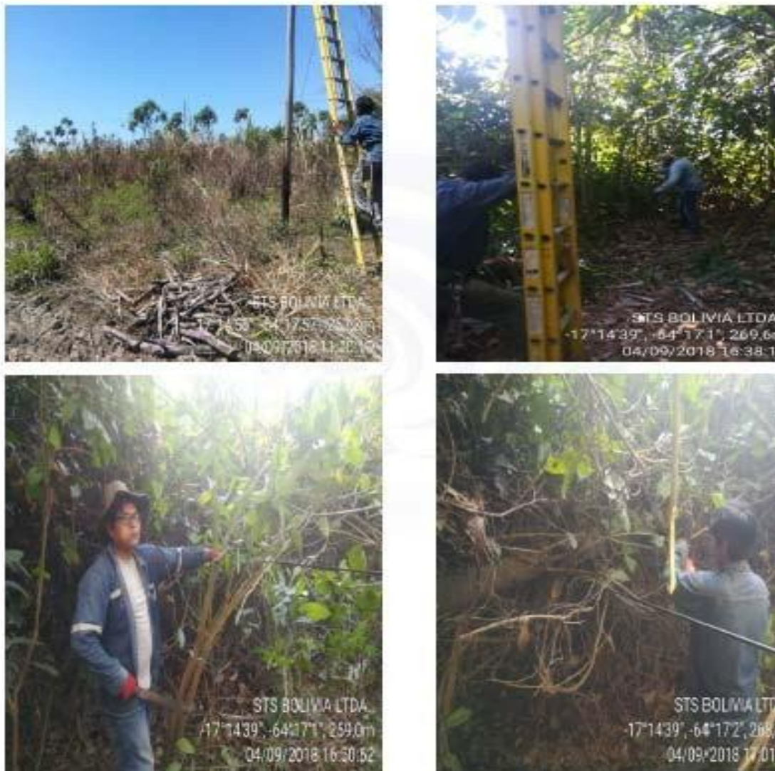
Figura 7 Personal liberando el cable de fibra óptica afectada por ramas de árboles
