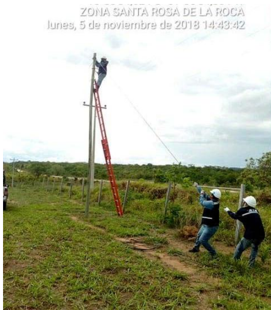
Figura 19 Retesado de cable de fibra óptica
