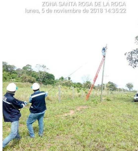
Figura 19 Retesado de cable de fibra óptica
