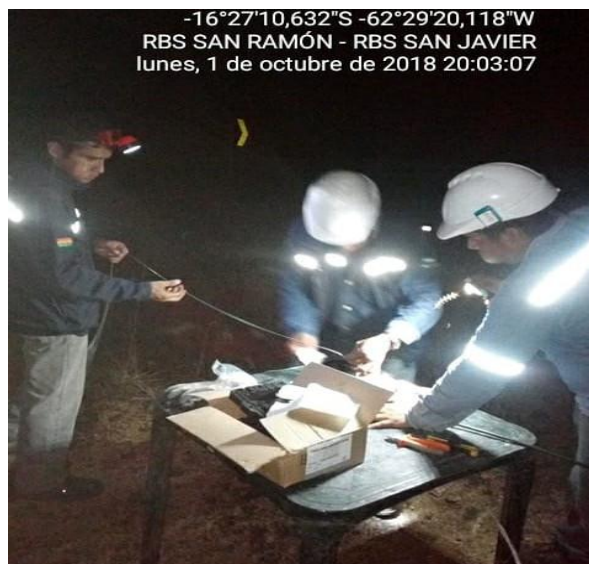
Figura 27 Personal técnico trabajando en horario nocturno, atención de emergencia
