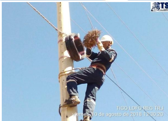
Figura 20. Limpieza de nido de pájaros en la instalación de ferretería cruceta
