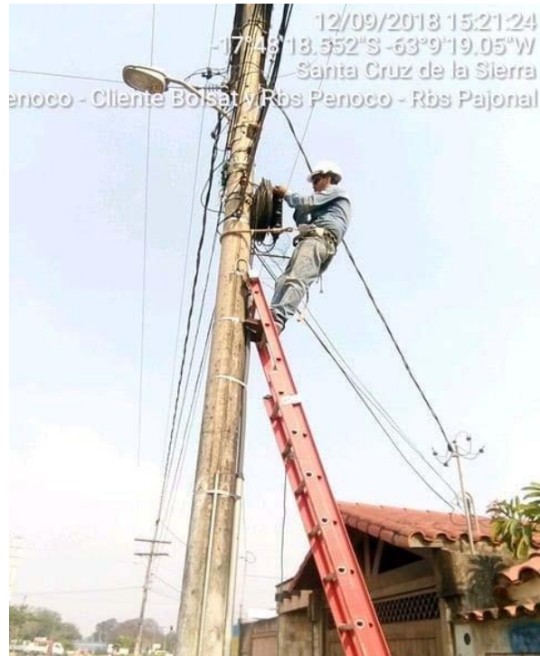
Figura 36. Personal técnico con casco, guantes de trabajo, Botines y cinturón de seguridad
