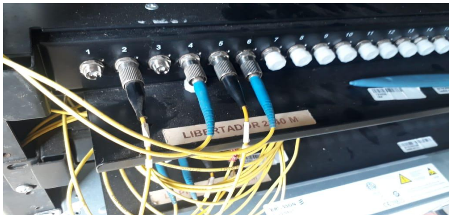
Figura 22. Conexión de pach cord en ODF
