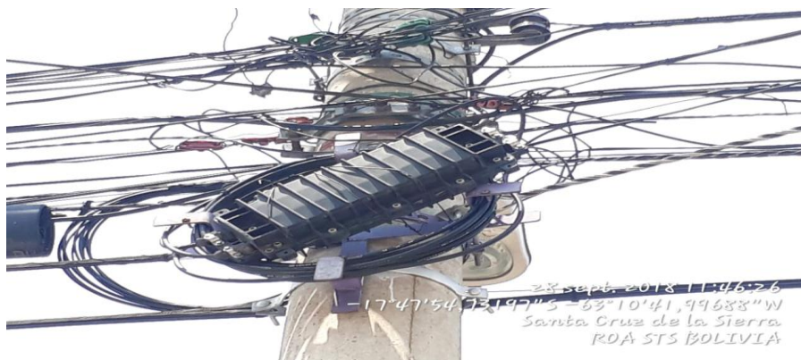
Figura 23. Instalación de caja de empalme en poste de fibra óptica
