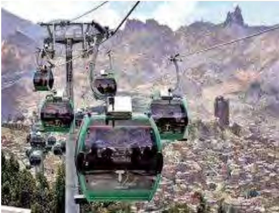
Fotografía No 8: Cabinas Línea Verde trayecto de la Estación Alto Obrajes
