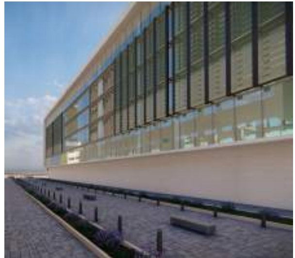
Imagen 81. Corredor peatonal, vista Noroeste Bloque de hospitalización.
