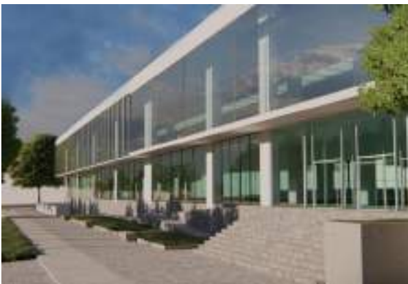
Imagen 82. Vista Sur, ingreso peatonal Unidad de Consulta externa.
