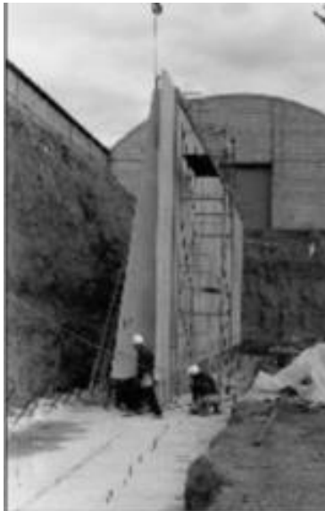
Fotografía 2: Muros de contención con contrafuertes
