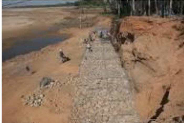
Fotografía 4: Muros de contención de gravedad
