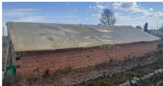
Figura 6. Exterior del invernadero
