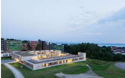
F9. Centro Psiquiátrico friedrichshafen, vista exterior
