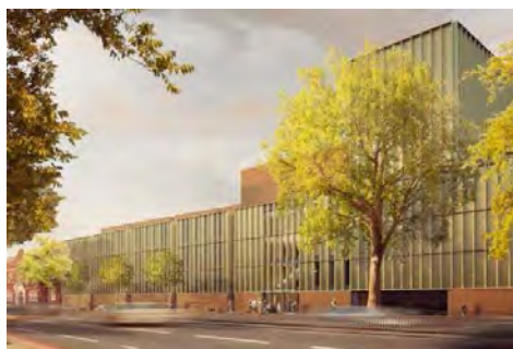
Ilustración 23 Nuevo Edificio para LAMDA
