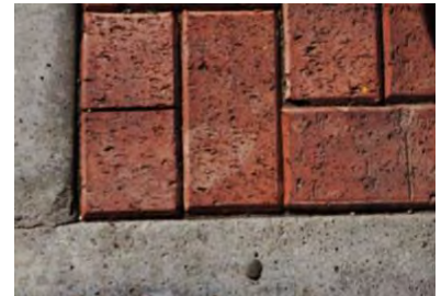
PAVIMENTO Y CORDÓN DE ACERA
