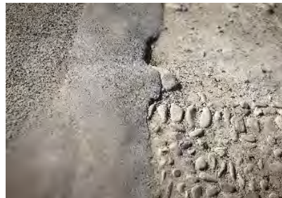
ASFALTO Y EMPEDRADO
