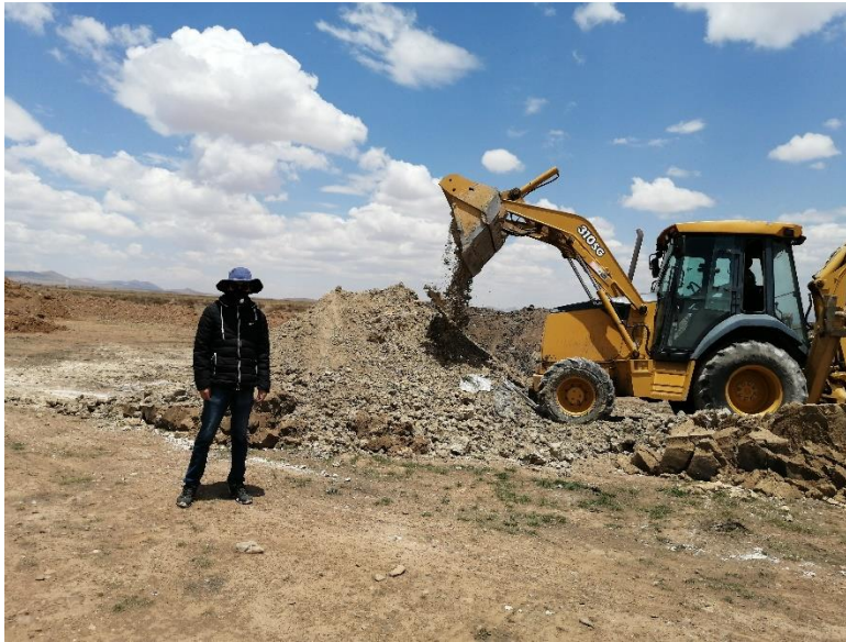
Fotografía 1: Movimiento con equipo de retroexcavadora de lodos de tierra de diatomeas
