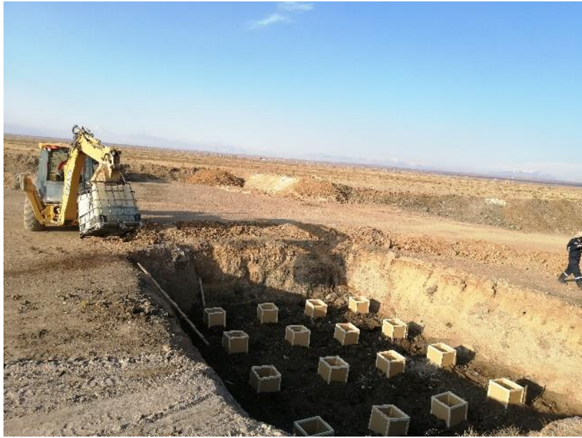
Fotografía 13: Traslado del tanque de agua al campo experimental.
