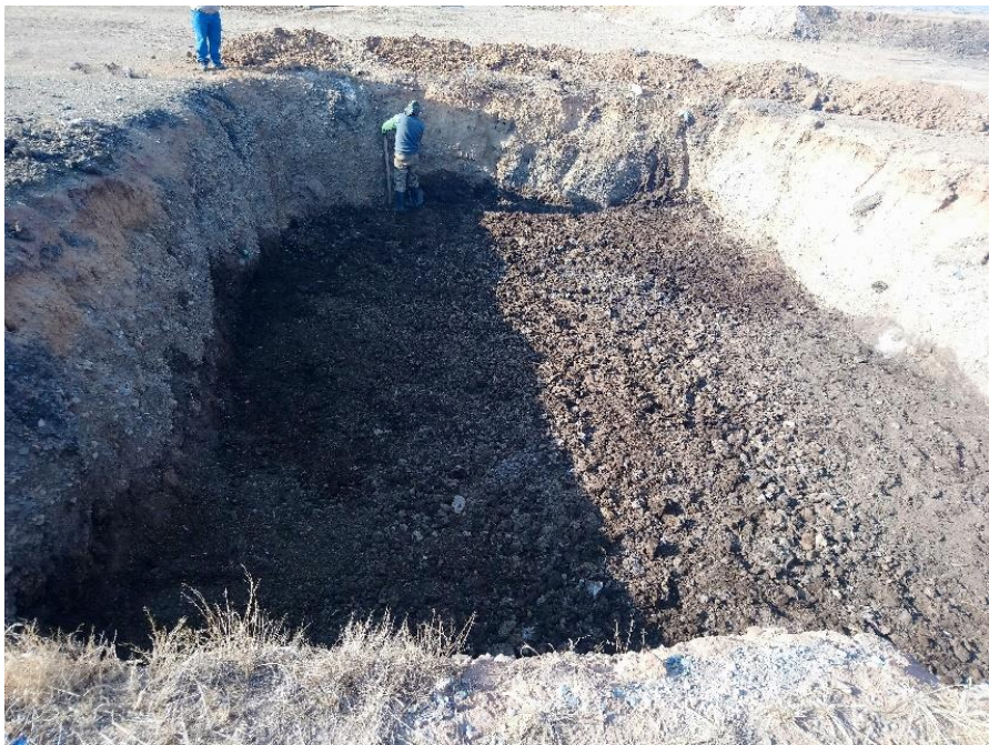
Fotografía 4: Preparación de terreno experimental.
