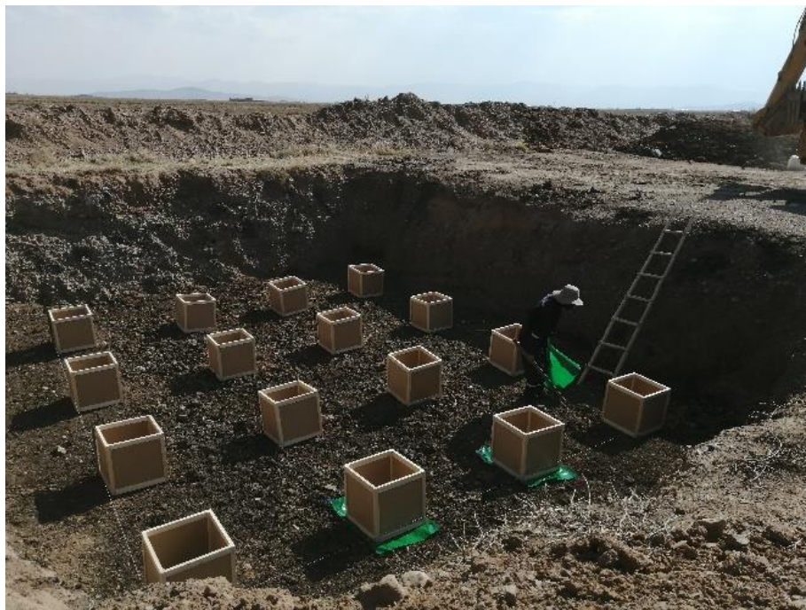
Fotografía 10: Protección de las bases de las cajas lombriarias.
