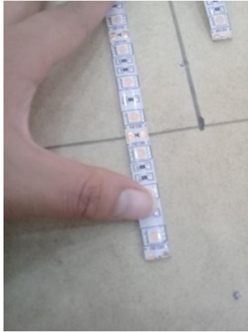
Figura 28: Instalación de luces, de iluminación la cinta ALED 5050 – IP65.
