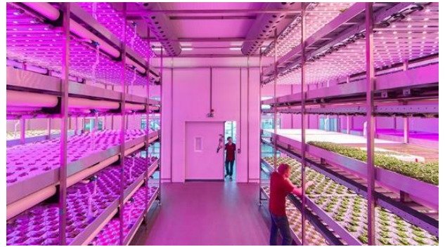
Figura 25: Proyecto innovatus de la marca Philips, cámara climatizada terminada.
