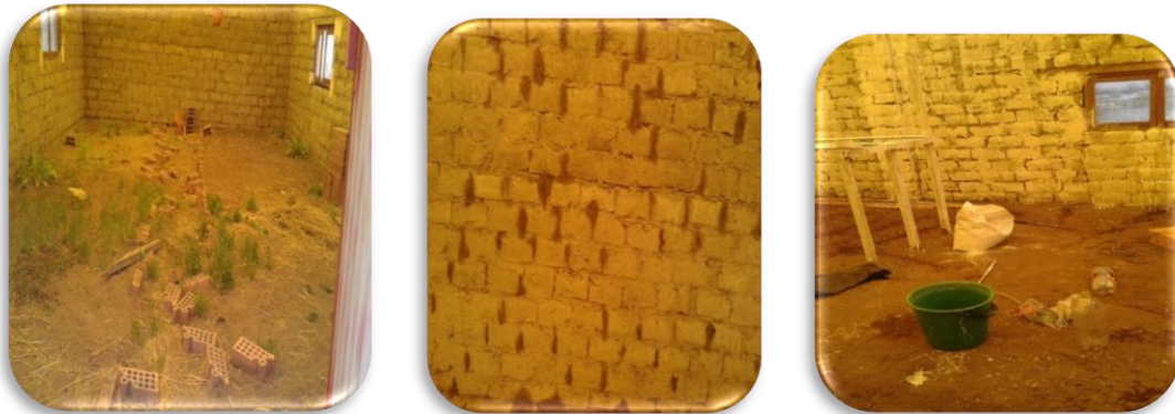
Figura 2. Limpieza, revoque y desinfección
