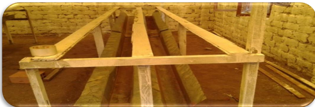
Figura 5. Canales de desagüe
