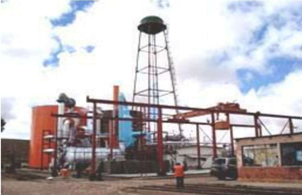
GRÁFICO N° 01 – ASPECTO INTERNO ACTUAL DE LA PLANTA, DESPUÉS DE SU RESTAURACIÓN (Fuente: Periódico “La Patria” – Oruro – Abril del 2012)
