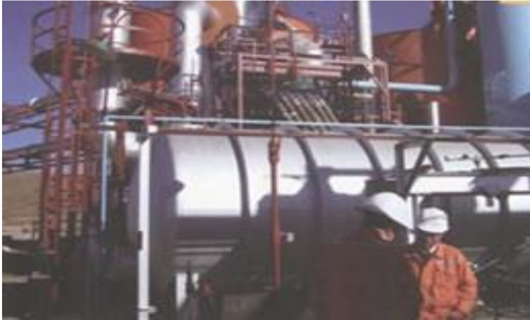
GRÁFICO N° 03 – VISTA DEL TANQUE PRINCIPAL ACTUAL DE LA PLANTA, DESPUÉS DE SU RESTAURACIÓN (Fuente: Periódico “La Patria” – Oruro – Junio del 2012)
