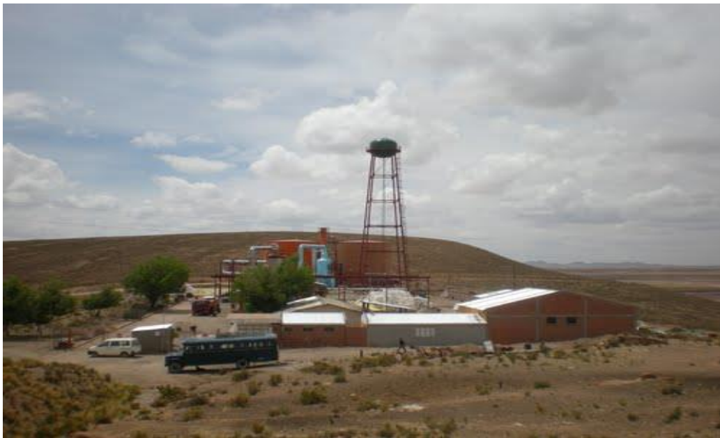
GRÁFICO N° 02 – ASPECTO EXTERNO ACTUAL DE LA PLANTA, DESPUÉS DE SU RESTAURACIÓN (Fuente: Periódico “La Patria” – Oruro – Abril del 2012)
