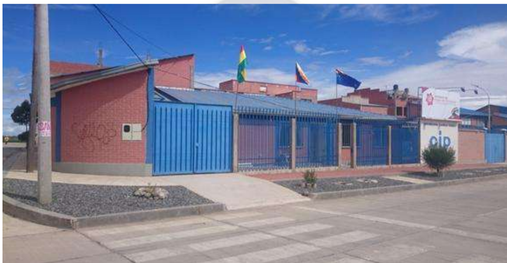
Figura 7 Vista lateral de la planta CIP Textil del Alto de La Paz
