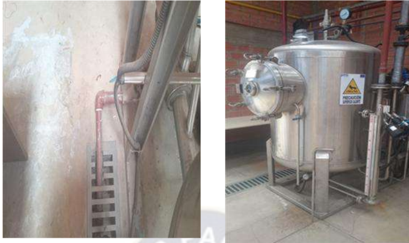
Figura 25 Conducto de salida que desecha el agua residual, proveniente de la autoclave de teñido de madejas
