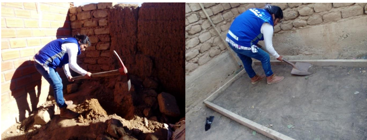
Figura 1. Preparación de la Platabanda
