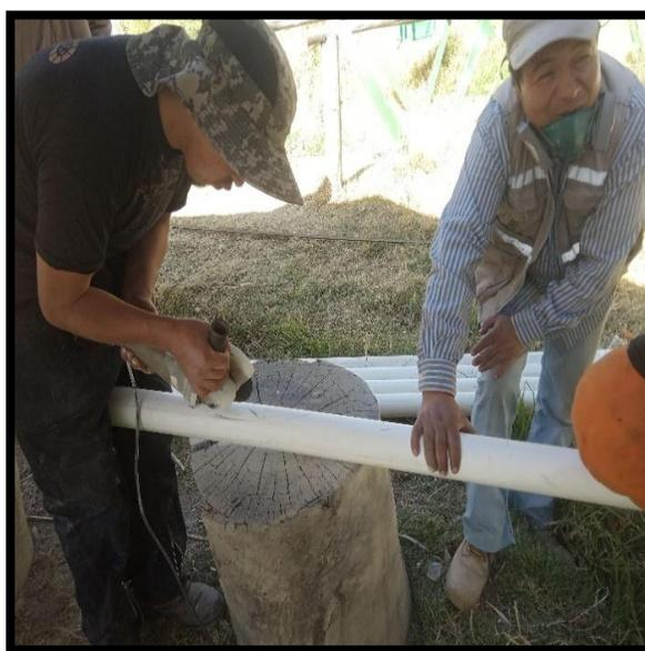
Corte de del tubo PVC de 3 in en forma longitudinal.
